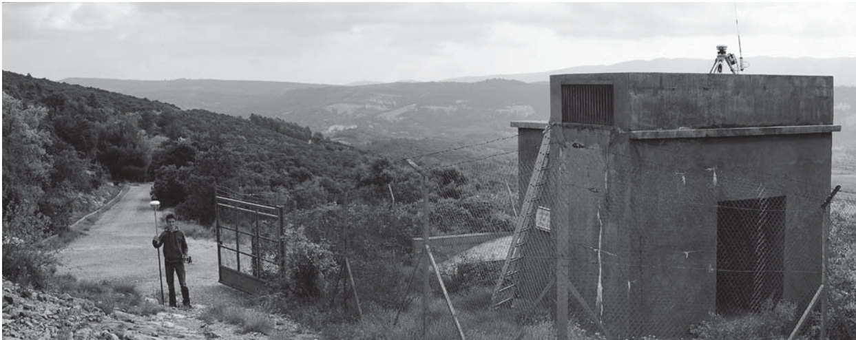
Le site de la sortie de secours du Laboratoire souterrain à bas bruit, à Rustrel. Photo : Simon Carrière
