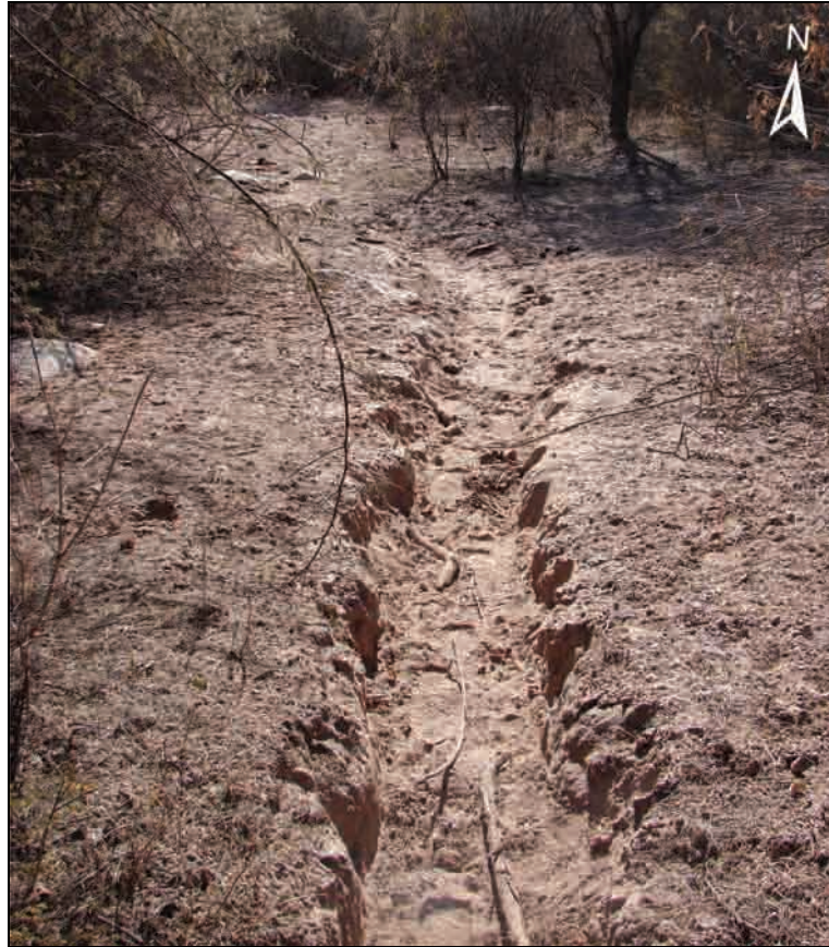
Figura VII.22. Otro ejemplo de profundización de la vía sobre una superficie friable. Fotografía del autor.
