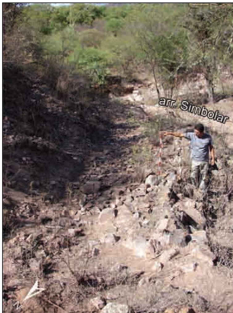
Figura VII.2. Camino con talud, muro de protección y excavación ladera adentro. Fotografía del autor.
