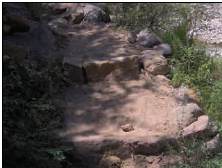
Figura VI.18. Camino reconstruido con escalonado y muro de contención actual. Anchura: 1,50 m. Fotografía del autor.
