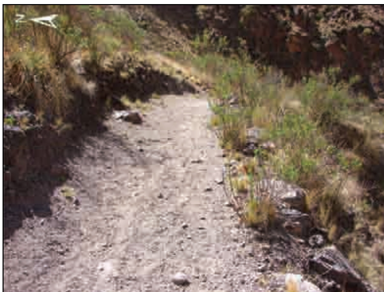
Figura VI.159. Camino tipo con talud y excavación dentro la ladera. El ancho del camino varía de 1,7 a 2,25 m. Fotografía del autor.
