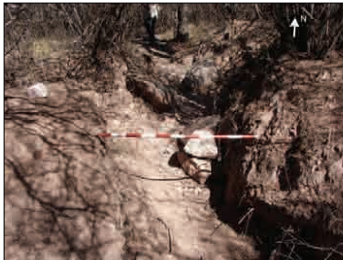
Figura V.27. Cauce del arroyo en donde desagua el canal descubierto en Piedra Hincada. Fotografía del autor.
