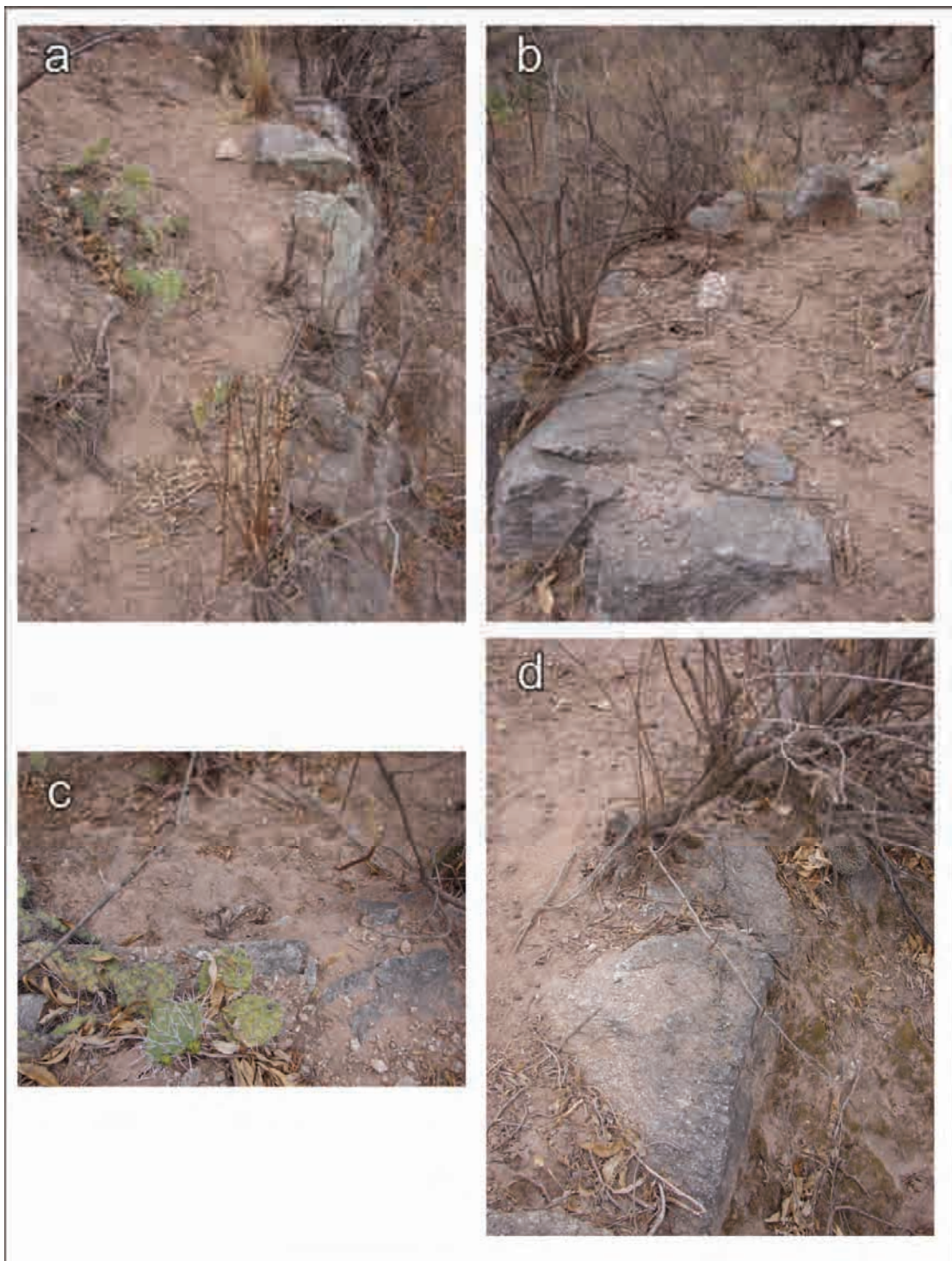
Figura V.72. Imágenes del talud o muro de contención sobre el segmento en cornisa: c, d) obsérvese las caras planas hacia el exterior del camino. Fotografías del autor.
