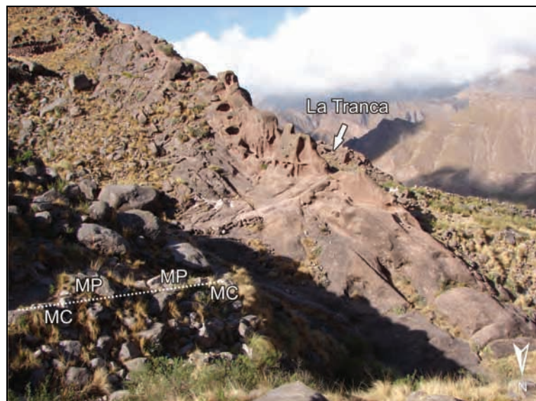
Figura VI.106. Segmento vial posterior a La Tranca: MP= muro de protección; MC= muro de contención. Fotografía del autor.
