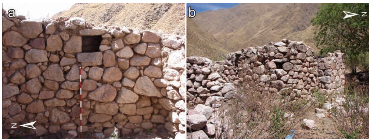
Figura VI.154. Puesto Sacha Uva: a) Vista exterior de una de las habitaciones del puesto; b) Vista interior de otra habitación. En ambos casos se puede observar la presencia de hornacinas. El pircado es doble, con mortero y calzado con lascas (piedras más pequeñas).
