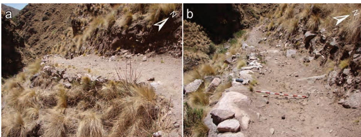
Figura VI.148. Camino con talud y excavación después de Mal Paso: a) Imagen tomada en las coordenadas 27° 32' 29.67" S; 67° 13' 37.74" O; 2823 msnm; b) El talud apenas sobresale en relación al nivel de la superficie del camino. Imagen tomada en las coordenadas (27° 32' 29.49" S; 67° 13' 36.48" O; 2817 msnm). Fotografías del autor.
