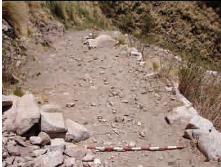
Figura VI.145. Camino de descenso de la altiplanicie en dirección a Mal Paso. Diseño en zigzag con talud y excavación dentro de la ladera. En la esquina inferior izquierda de la imagen se pueden observar los restos de un derrumbe. Fotografía del autor.
