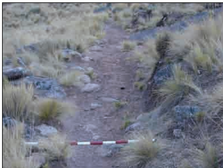
Figura VI.115. Camino con talud ladera abajo y excavación dentro de la ladera -ladera arriba- ( 27^{\circ} 33' 49.18'' S; 67^{\circ} 15' 12.34'' O. Altura: 2738 msnm).
