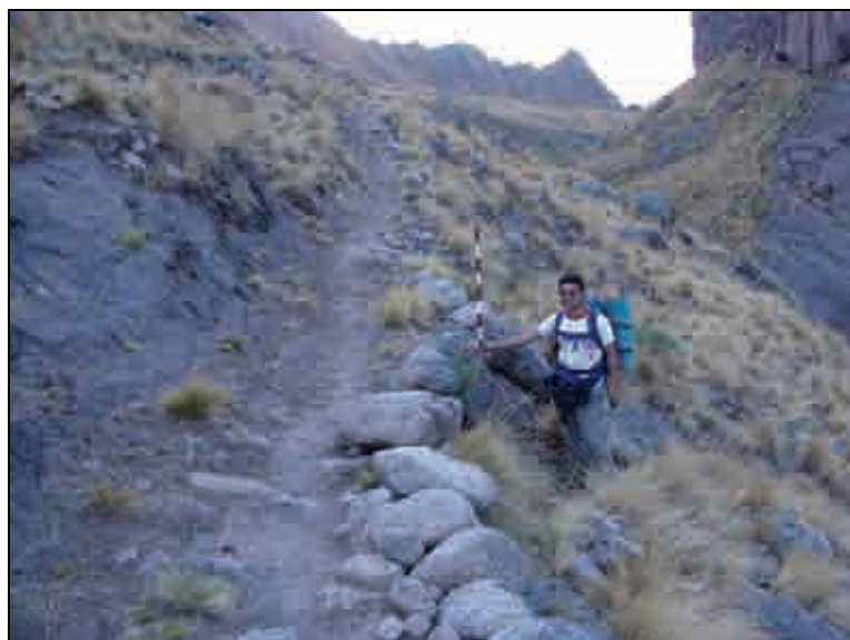
Figura VI.112. Camino con talud y muro de protección -ladera abajo- y con afloramiento a manera de muro de retención -ladera arriba- ( 27^{\circ} 33' 53.77'' S; 67^{\circ} 15' 14.26'' O. Altura: 2736 msnm). Ancho del camino: 1,15 m. Fotografía del autor.
