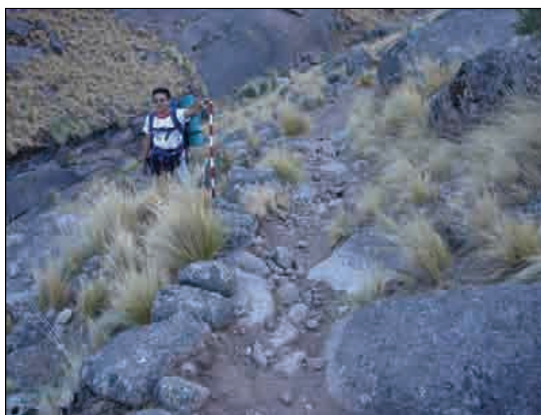
Figura VI.113. Camino con talud ladera abajo y muro de retención ladera arriba ( 27^{\circ} 33' 53.40'' S; 67^{\circ} 15' 14.24'' O. Altura: 2736 msnm). Fotografía del autor.
