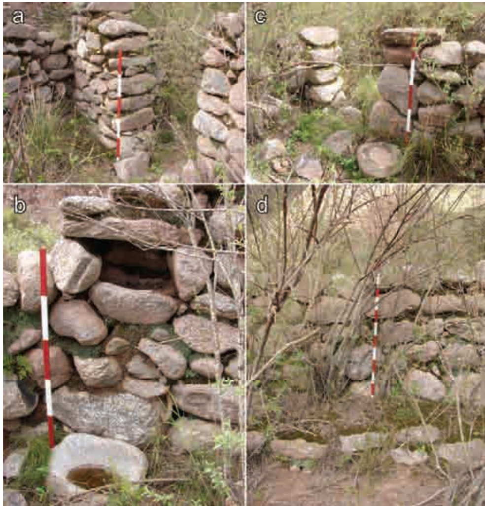
Figura VI.47. Puesto abandonado ubicado por detrás de las ruinas de la escuela: a) vano de acceso y muro de unos de los recintos; b) muro con presencia de hornacina. Obsérvese la unidad de molienda móvil apoyada sobre el piso; c) unidad de molienda cercana a un vano de acceso; d) muro bajo o banqueta. Fotografías del autor.
