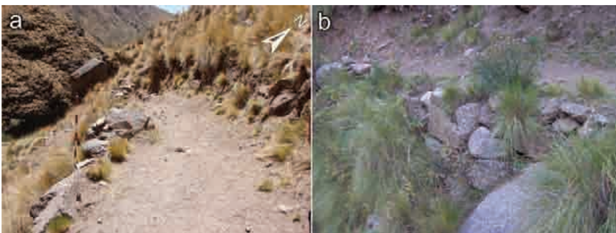
Figura VI.149. Camino con talud y excavación después de Mal Paso: a) Imagen tomada en las coordenadas 27° 32' 26.66" S; 67° 13' 31.41" O; 2793 msnm. Fotografías del autor.
