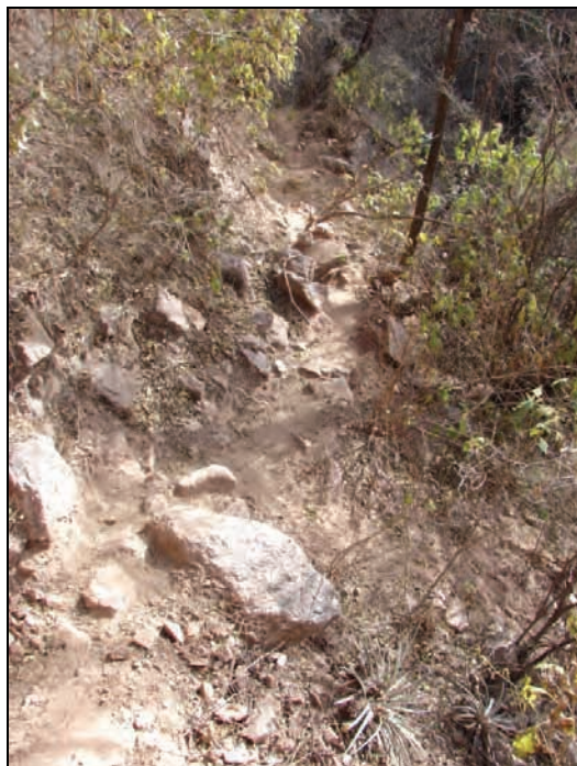
Figura V.63. Perturbación producida por deslizamiento de rocas. Fotografía del autor.
