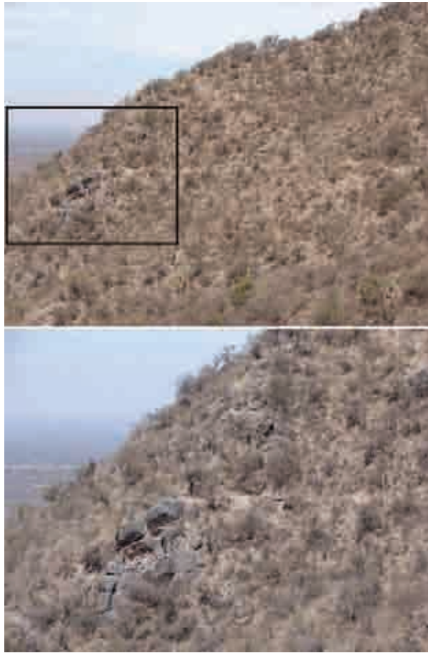
Figura V.76. Traza del camino sobre la ladera oriental del Co. Shincal. Fotografía del autor.
