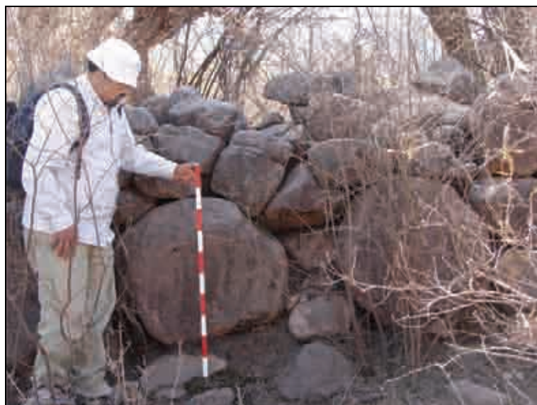
Figura VII.38. Sitio Paraje La Aguada: pared norte del R1. Obsérvese las caras planas de los cimientos dispuestas hacia el interior del recinto.
