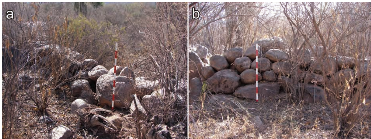
Figura VII.40. Sitio Paraje La Aguada: a) Muro oriental correspondiente al EA2; b) Muro norte continuo al anterior. Escala: 1 m. Fotografías del autor.
