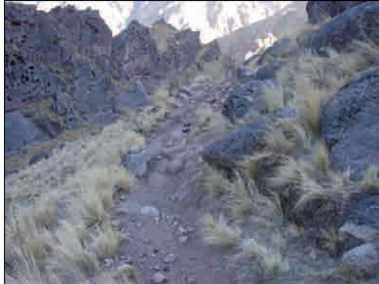
Figura VI.111. Camino con talud ladera abajo y muro de retención ladera arriba (27° 33' 57.34" S; 67° 15' 14.79" O. Altura: 2735 msnm). Fotografía del autor.
