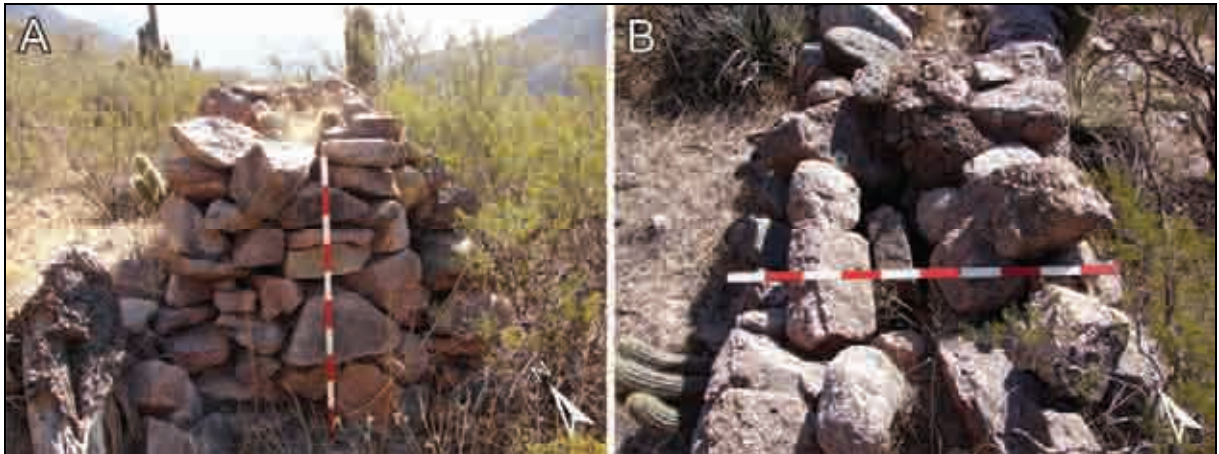
Figura VII.63. Sitio Tambillo Nuevo. Conjunto I, Subconjunto I: A) Paramento lateral interno de la puerta que comunica los espacios “b” y “c”; b) Vista en planta del muro que separa los espacios “b” y “c”. Escala: 1 m. Fotografías del autor.
