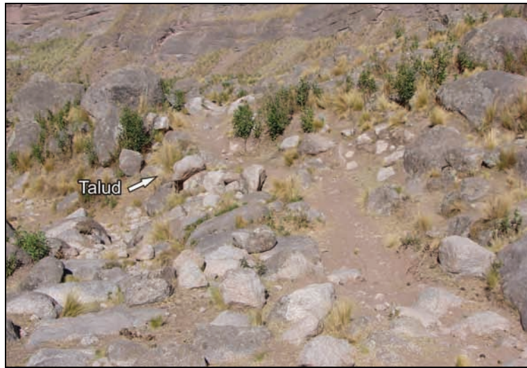
Figura VI.94. Camino con talud o muro de contención sobre superficie eluvio-eólica (Altura: 2626 msnm). Fotografía del autor.
