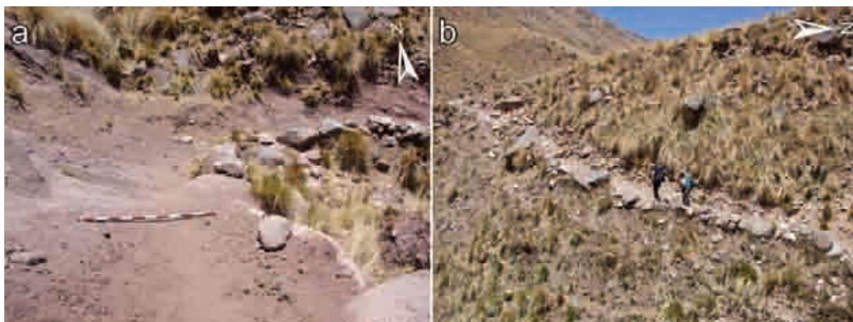
Figura VI.142. Camino con talud y excavación. Obsérvese la baja altura del talud.
