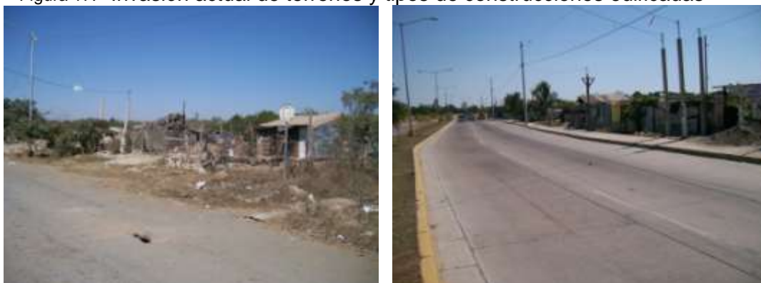
Figura 17. Invasión actual de terrenos y tipos de construcciones edificadas
