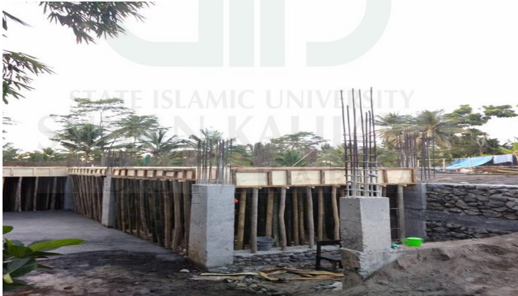
V. Proses pembangunan asrama putra
