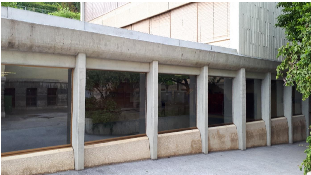
Face Sud de la piscine du bâtiment E (en haut)
