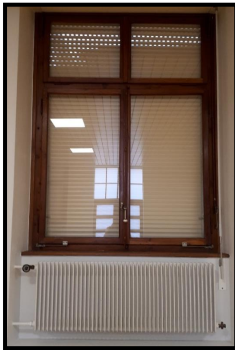
Image 5 : Radiateur type du bâtiment B (partie non-rénovée)
