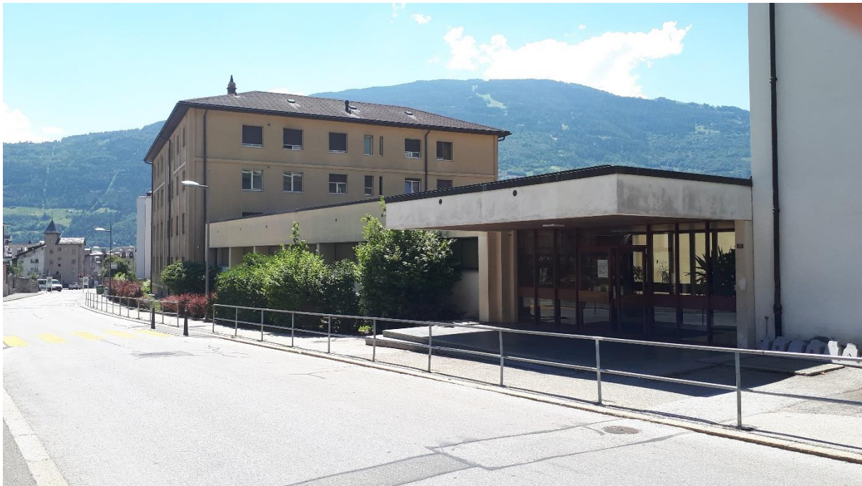
Face Est et liaison des bâtiments C et D (à droite)
