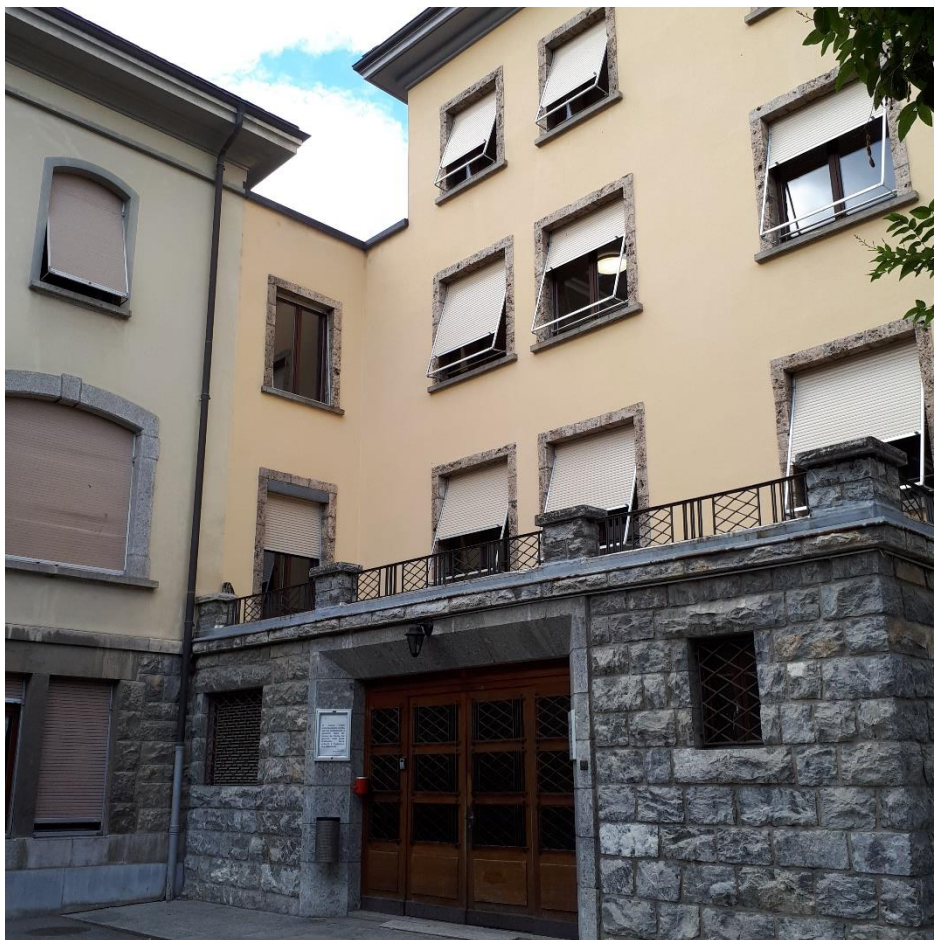
Face Ouest du bâtiment B (en haut) avec entrée principale du complexe (en bas) et bâtiment A (à gauche)
