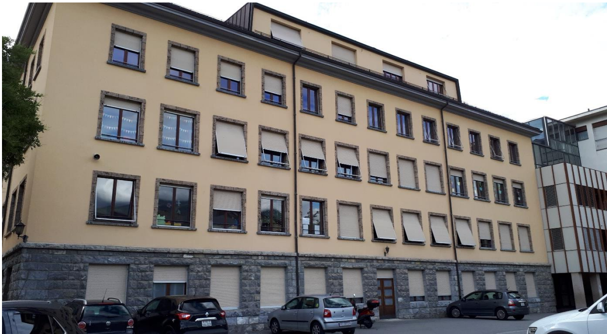
Face Sud et liaison des bâtiments B et C (à droite)
