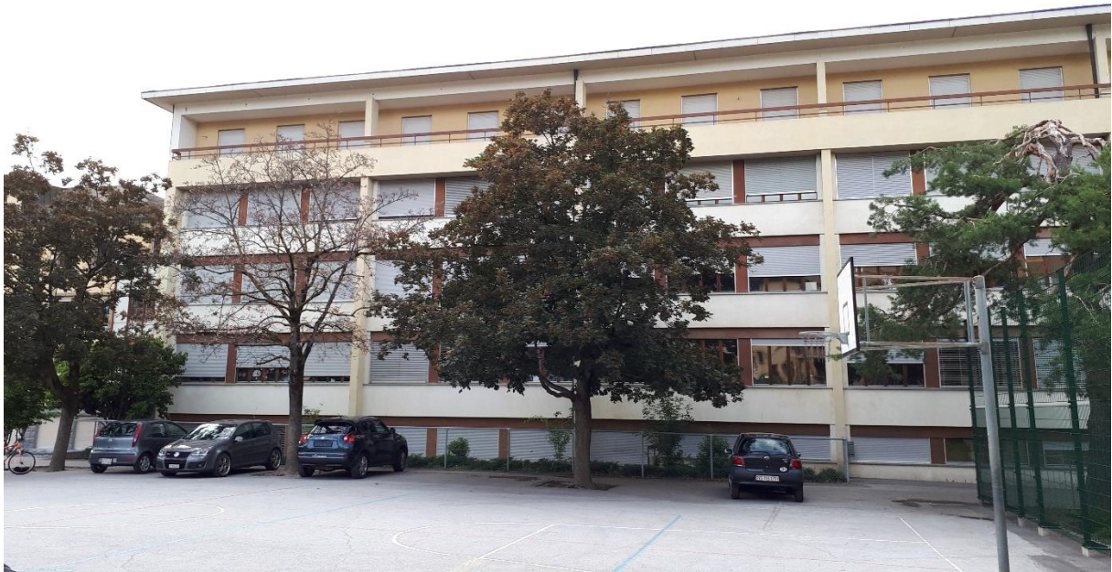
Face Sud et terrain de sport extérieur
