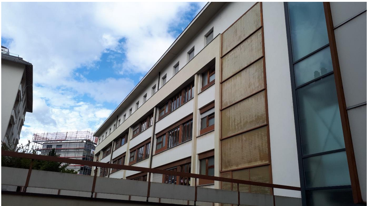
Face Nord (à gauche), façade en plastique alvéolaire (au centre), et ascenseur intérieur (à droite)
