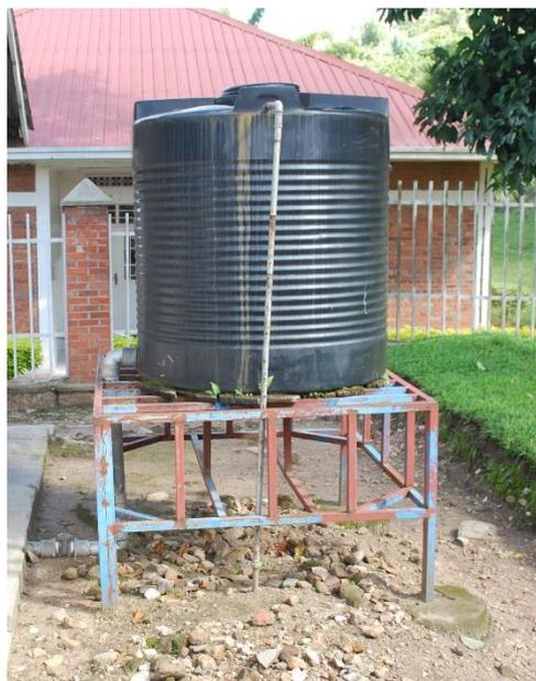
Fig. 24: réservoir à eau de 2 m<sup>3</sup>, tel qu'utilisé au Rwanda pour recueillir l'eau de pluie. Photo prise le 29.05 sur le site de l'hôpital de référence de Kibuye.
