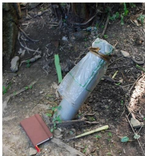
Fig. 15: accès prévu pour l'injection de déjection humaine dans le dôme et scellé en attente de finalisation. Photo prise le 31.05 sur la propriété de Grégoire KABERA.
