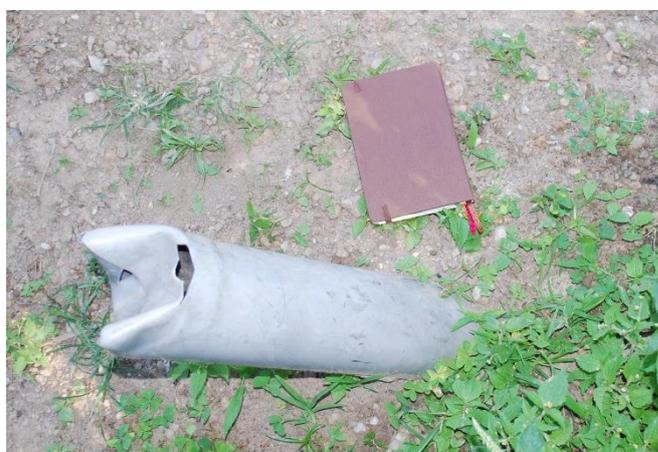
Fig. 8 : accès direct à la chambre de digestion, prévu pour l'utilisation d'excréments humains comme substrat. Echelle : longueur du calepin = 17 cm. Photo prise le 31.05 sur la propriété de Léonard NTIVUGURUZA.
