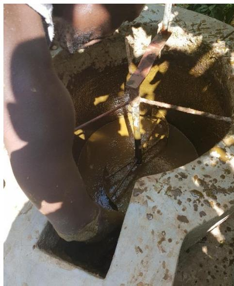
Fig. 7 : chambre d'alimentation couplée au digesteur et munie d'un bouchon permettant d'homogénéiser le substrat avant son injection dans la chambre de digestion. Photo prise le 29.06 dans la propriété de Simon NTAGAHINDA.
