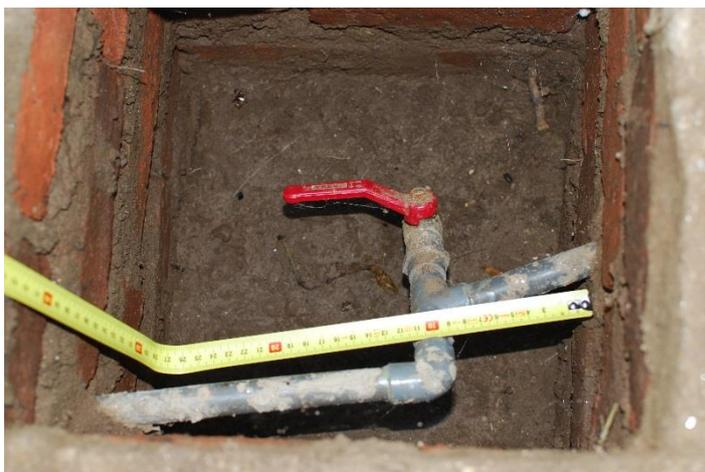
Fig. 16: robinet de purge permettant l'évacuation de l'humidité dans les canalisations de gaz, située après le robinet du biogaz (conduite en bas à droite), au sommet du dôme. Photo prise le 04.06 sur la propriété de Simon NTAGAHINDA.
