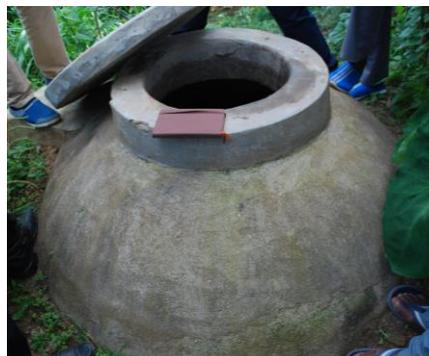
Sommet du dôme de la chambre d'évacuation d'un digesteur de type CAMARTEC, construit en 2017 dans le cadre du programme FONERWA au Rwanda.
