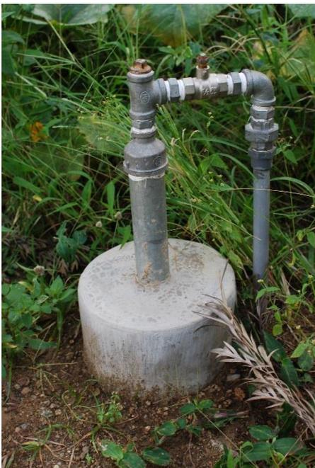
*Fig. 17: robinet de gaz présent au sommet du dôme de la chambre de digestion. Les deux écrous permettent la fermeture de la sortie de gaz, soit avec une clé à tube (gauche) soit avec un robinet amovible (droite). Photo prise le 4 juin 2018 sur la propriété d'Éric NYANDWI.*
