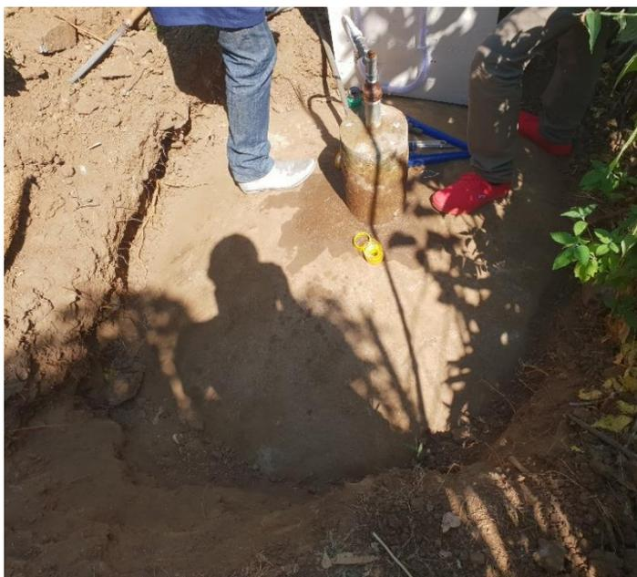
*Fig. 18: contrôle de l'intégrité du dôme de la chambre de digestion au moyen d'eau savonneuse. L'absence de bulle permet d'attester du bon état général du dôme. Photo prise le 11 juillet 2018 sur la propriété de S. NTAGAHINDA.*
