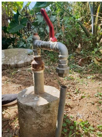
Fig. 13: robinet du biogaz, situé au sommet du dôme (enterré) et début de la canalisation permettant l'acheminement du gaz vers la cuisine. Photo prise le 28.06 sur la propriété de Simon NTAGAHINDA.
