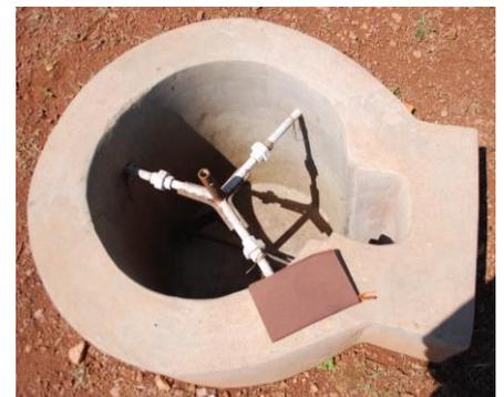
Chambre d'alimentation permettant l'injection de substrats dans un digesteur de 100 m<sup>3</sup> à la prison de Mageragere, près de Kigali (Rwanda).
