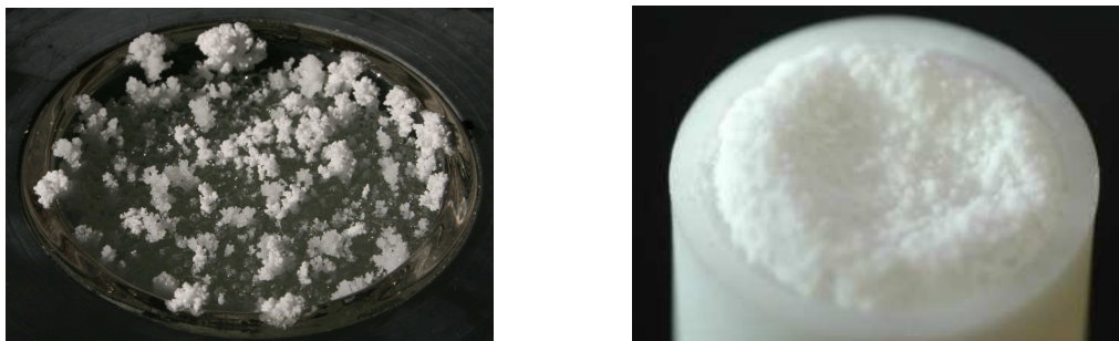
a) b) FIG.3 - Exemple d'efflorescence chou-fleur (a) et d'efflorescence croûte (b).
