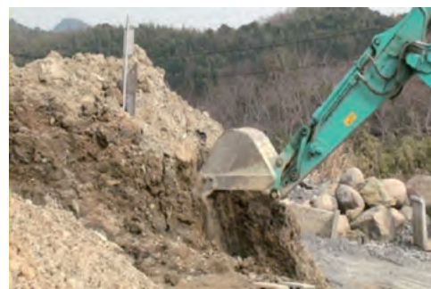
(b) P8 を掘削する様子
