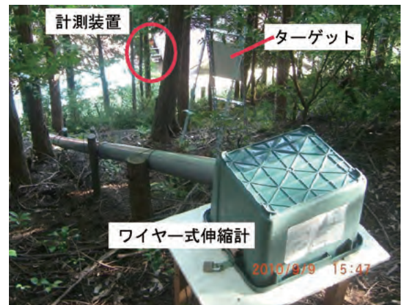
図7.4 定点観測実験のターゲット設置
