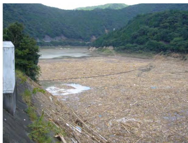
図-1 ダム流木 (椿山ダム, 2011年9月撮影)
