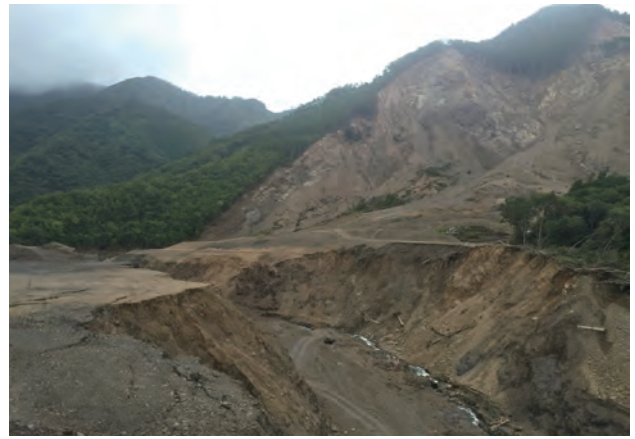
図4 十津川村栗平地区の災害現場
