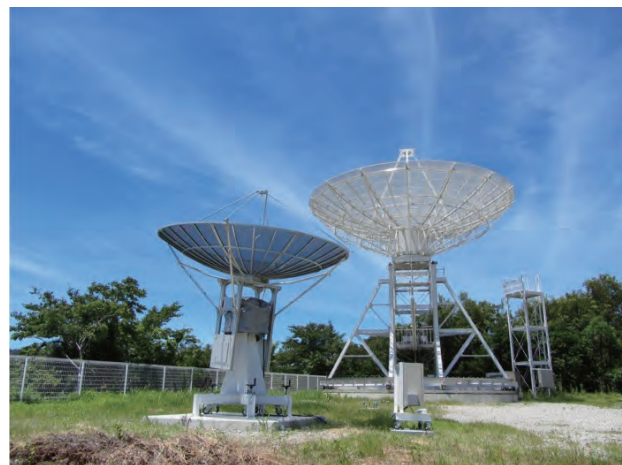
図1 12mアンテナと3mアンテナ(和歌山大学キャンパス 電波観測通信施設)
