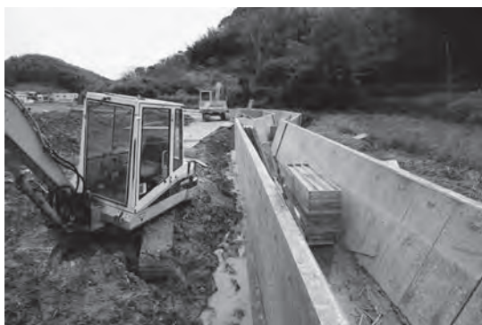
図11 改修中の用水路(2014年12月14日撮影)
