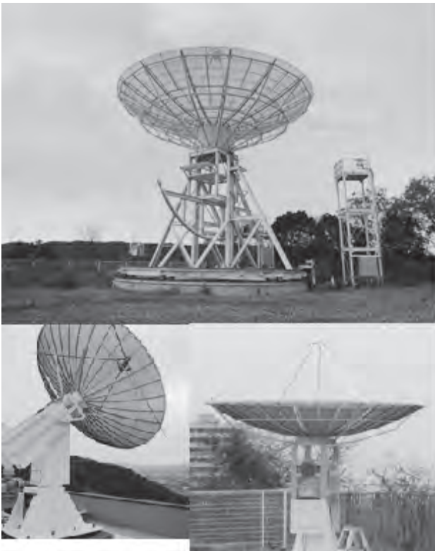
図2 和歌山大学内のアンテナ (上: 電波通信観測施設12mアンテナ, 右下: 電波通信観測施設3mアンテナ, 左下: 教育学部屋上3mアンテナ)
