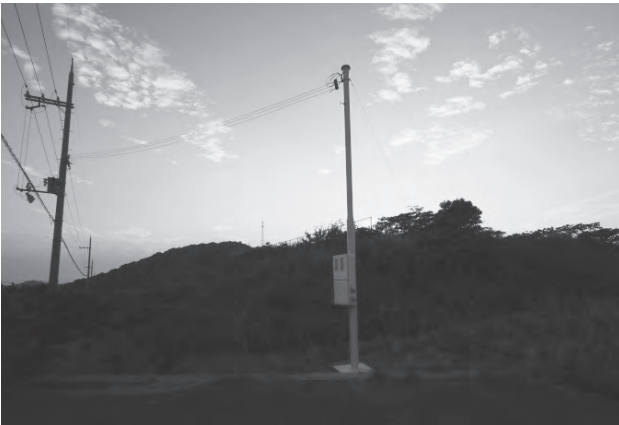
図9：電力・インターネット回線敷設
