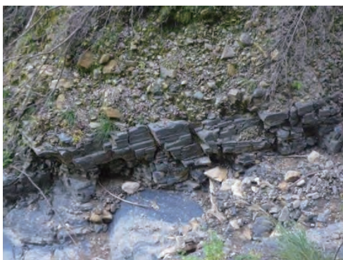
写真-5 節理面・層理面で緩んだ泥質互層 (新宮市九重, 2013年12月7日撮影)
