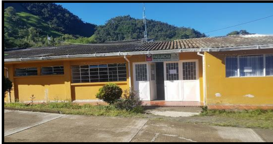
Figura 6. Fotografía del PUESTO DE SALUD en Pasuncha. Tomado de Google Earth
