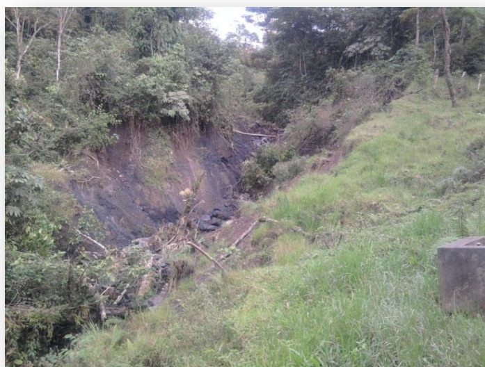
Figura N° 8: problemas de erosión en la parte del nacimiento
