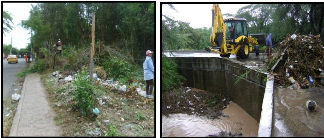
Fotografía 2. y Fotografía 3. Recolección de escombros puntos críticos de Municipio
