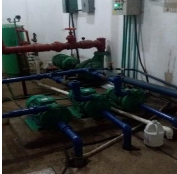
Imagen 5. Sistema Hidráulico - Primer Piso.
