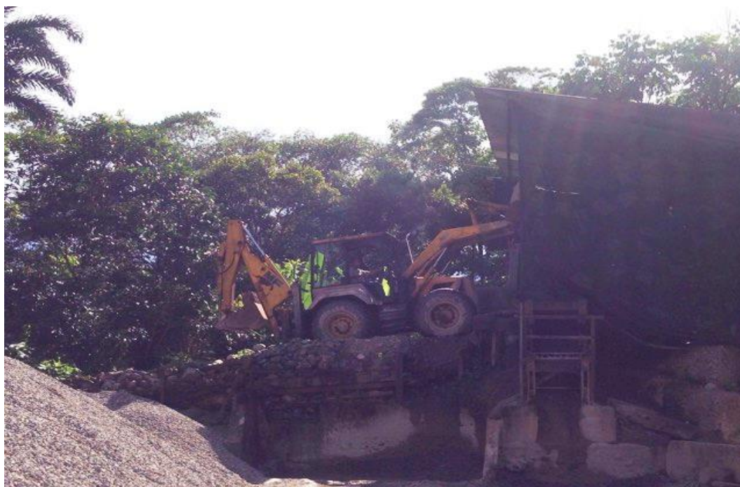
Imagen 12. Cargue de material pétreo a máquina trituradora.
