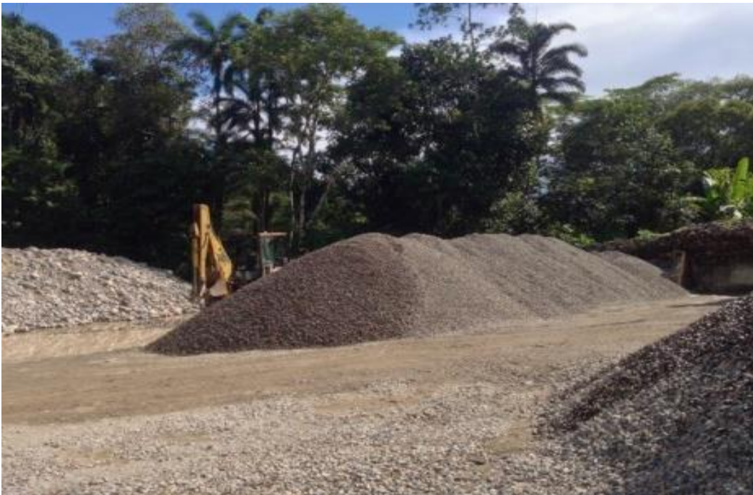
Imagen 10. Acopio de materiales
