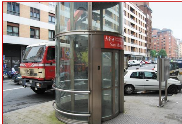
Figura 34: Ascensores Metro Bilbao
