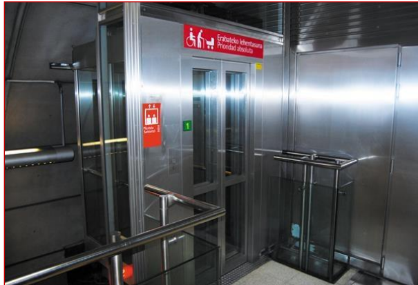
Figura 35: Salida ascensor interior frente a andenes
