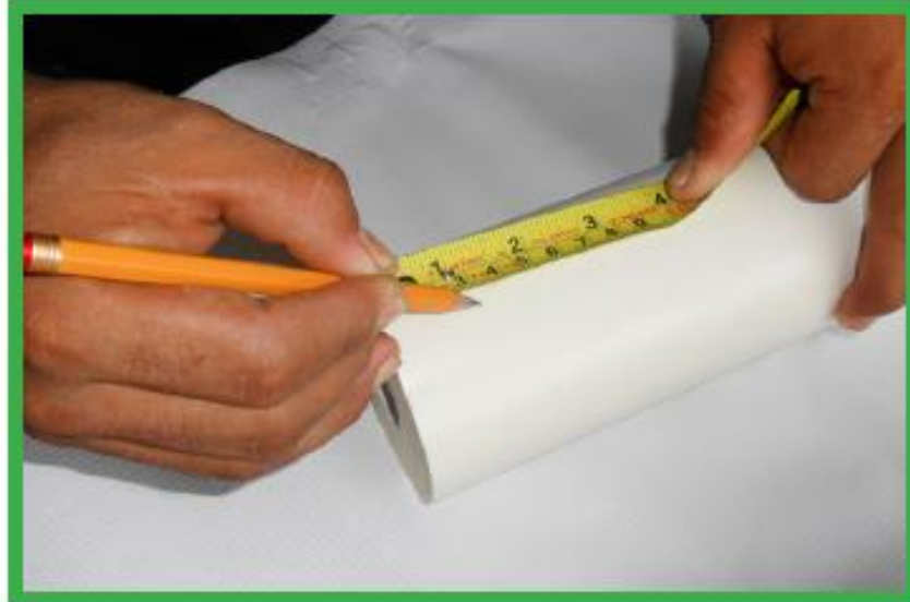
Figura 16. Marca de trazados para cortar la tubería preaislada.
