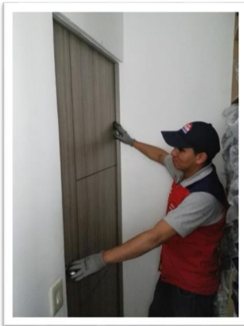
Imagen 20: Revisión de los Productos Instalados Fuente: Suministrada por la compañía
