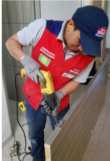
Imagen 15: Instalación de Bisagras Sobre la Puerta Fuente: Suministrada por la compañía
