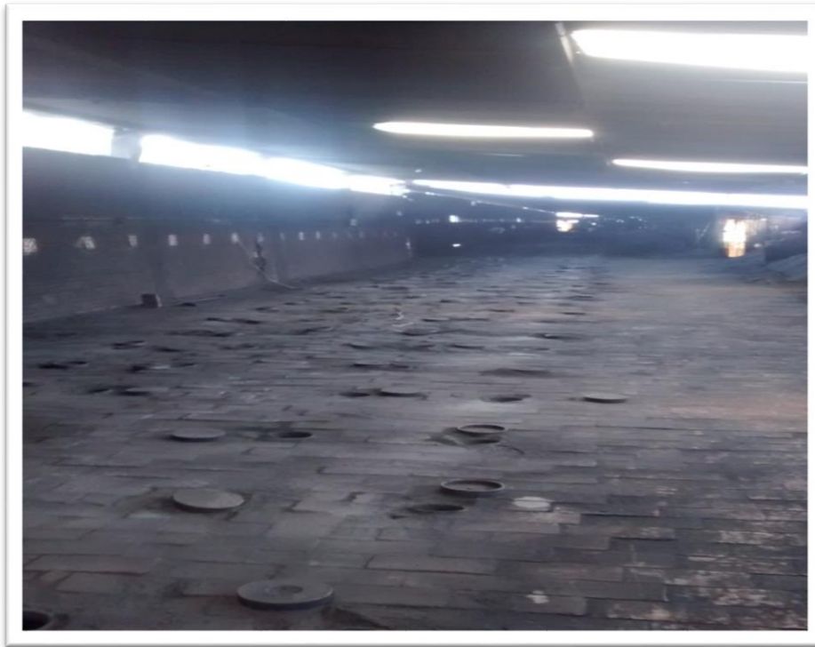
Figura 31. Agujeros para la inyección de carbón ubicados en el techo del horno Hoffman Semicontinuo en Ladrillera los Cristales
