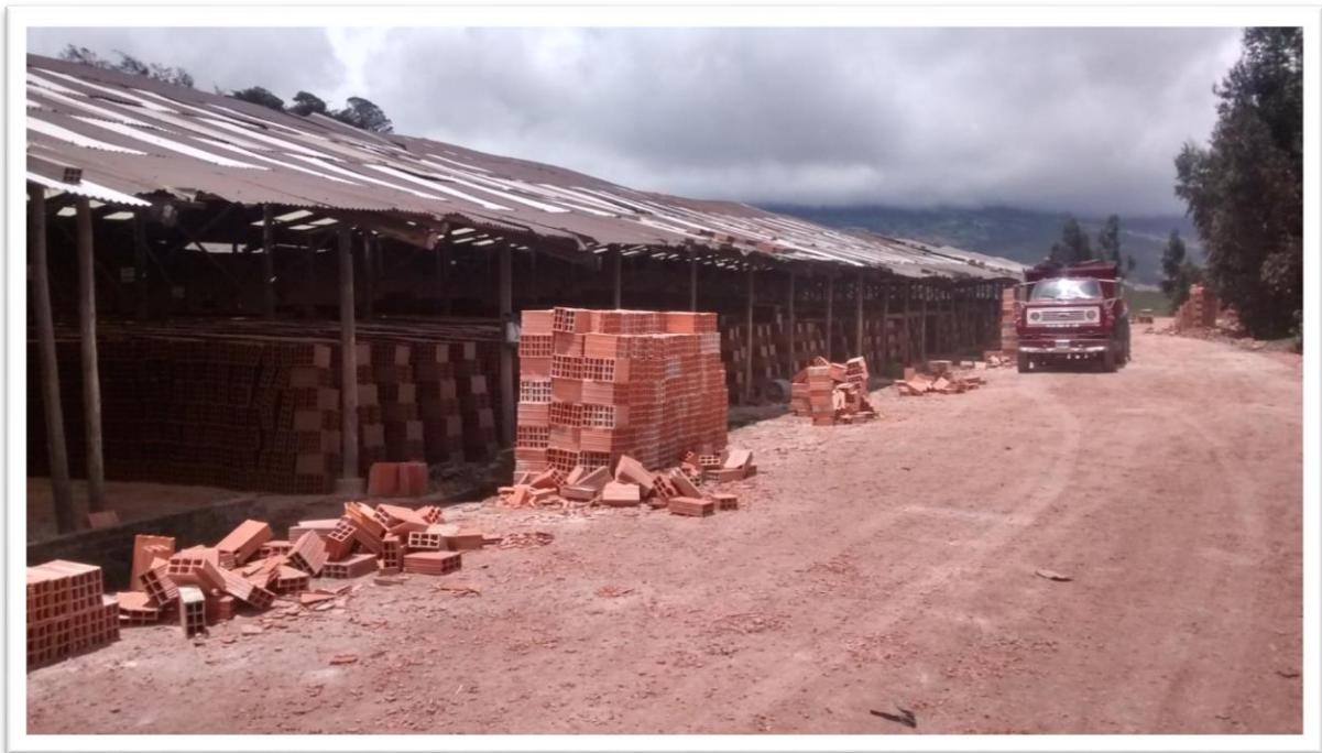
Figura 34. Patio de almacenamiento de bloque de arcilla terminado en Ladrillera Los Cristales
