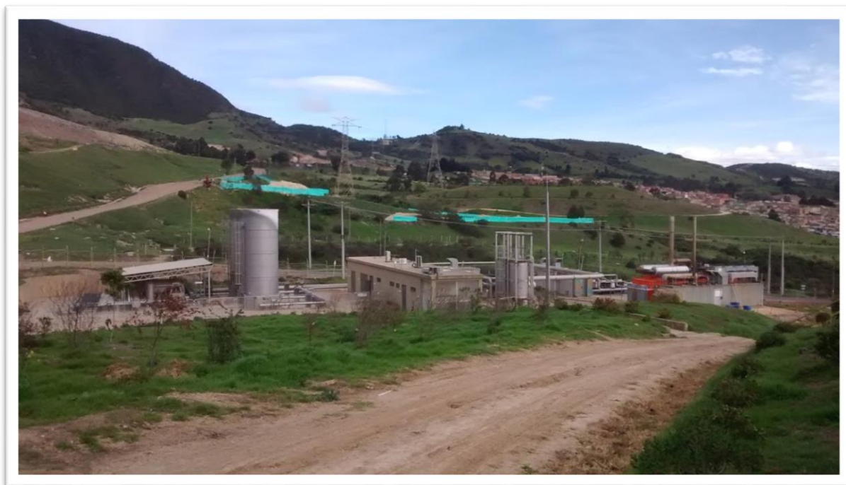
Figura 41. Planta de Biogás en el relleno sanitario Doña Juana
