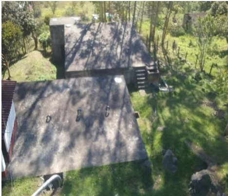
FOTO 6 Cuartos de Control
