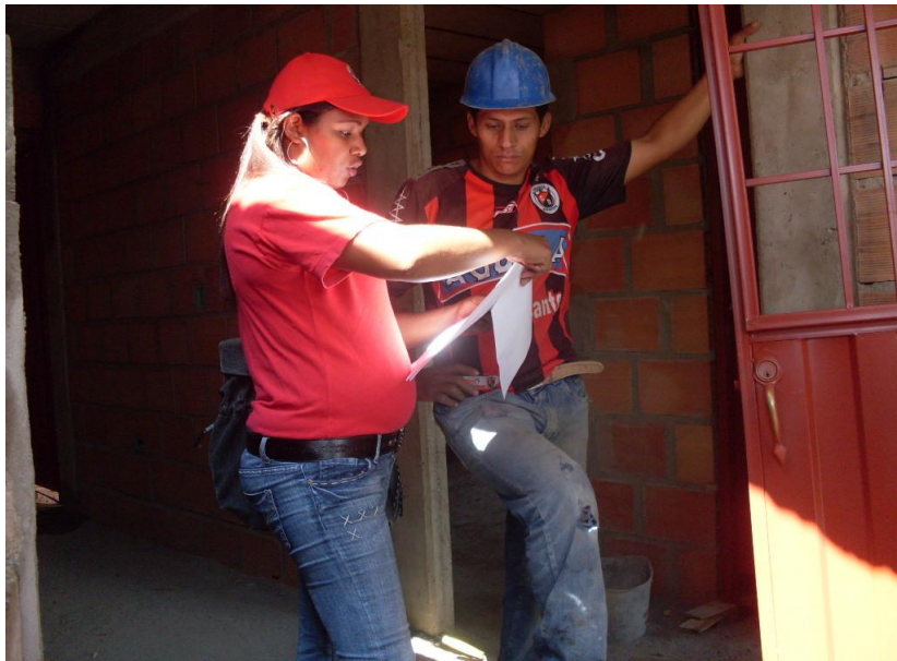
Fotos 17 y 18: Entrevista a los trabajadores de la construcción en la obra Ciudadela El Progreso que desarrolla la Constructora Odicco - Metrovivienda
