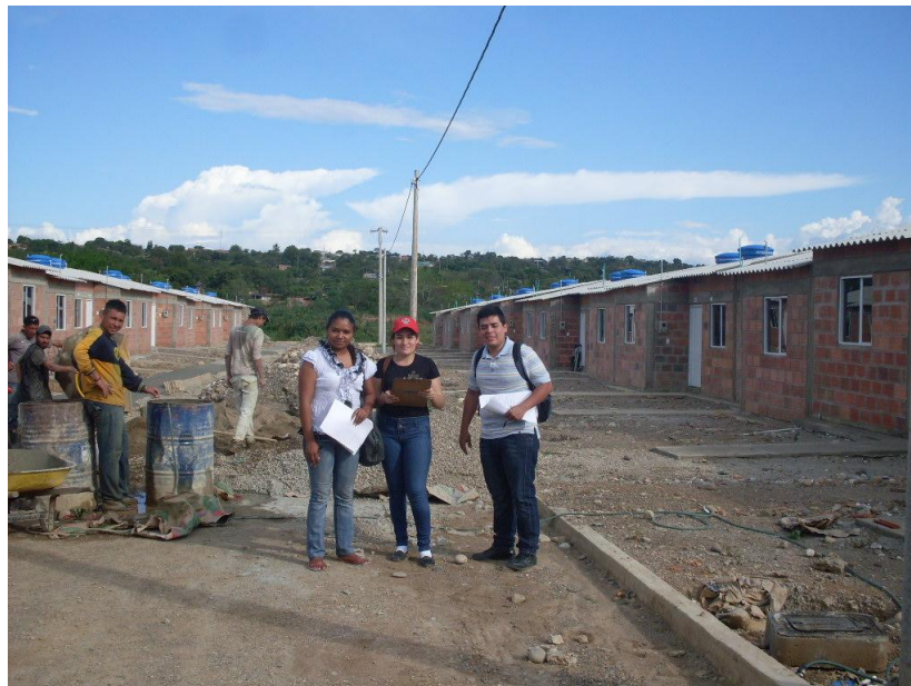
Fotos 13 y 14: En la obra Ciudadela El Progreso que desarrolla la Constructora Odicco – Metrovivienda
