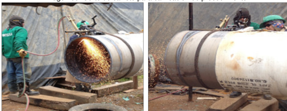
Imagen 33. Corte de carreto para calificación de procedimiento
