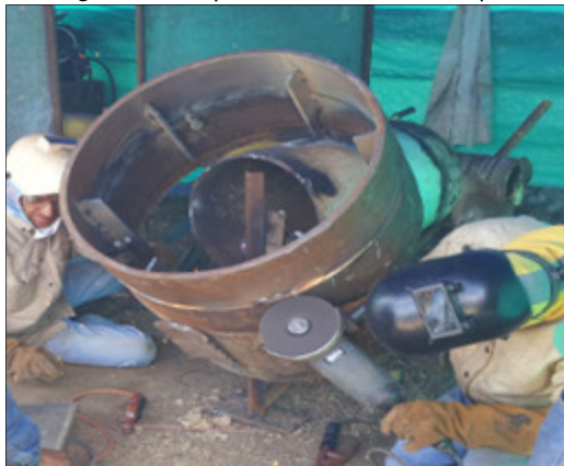
Imagen 37. Limpieza de escoria entre pases
