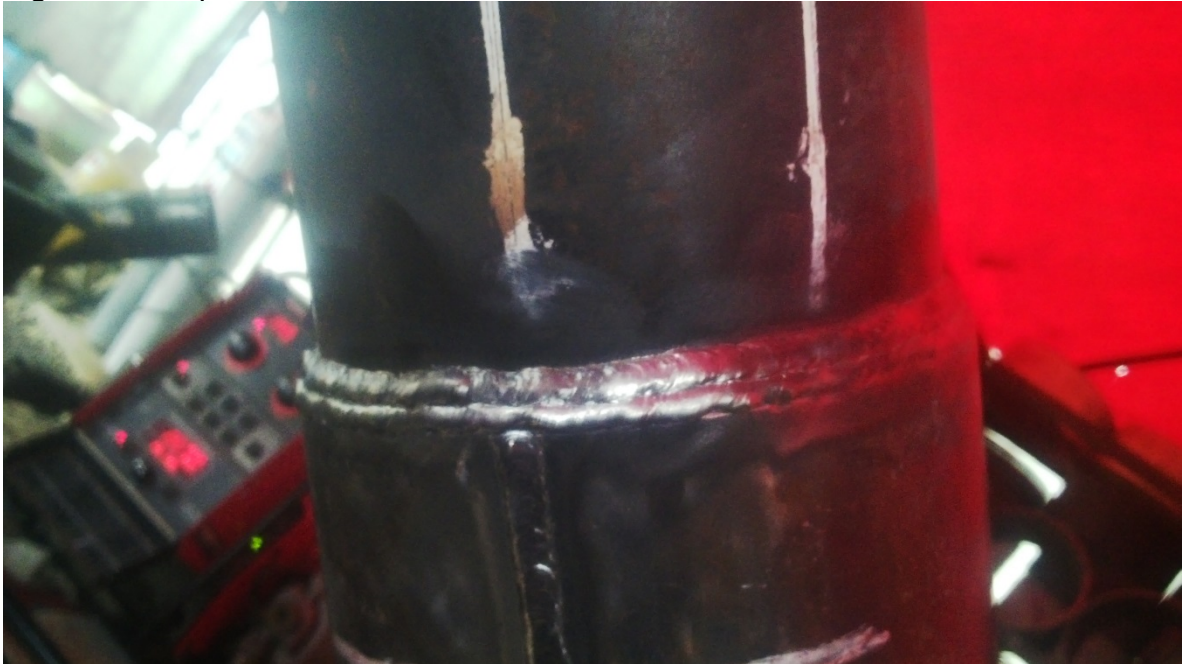
Figura 29. Inspección Visual Junta Camisa
