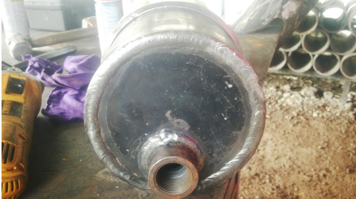
Figura 18. Soldadura de Tapa y Half-Coupling
