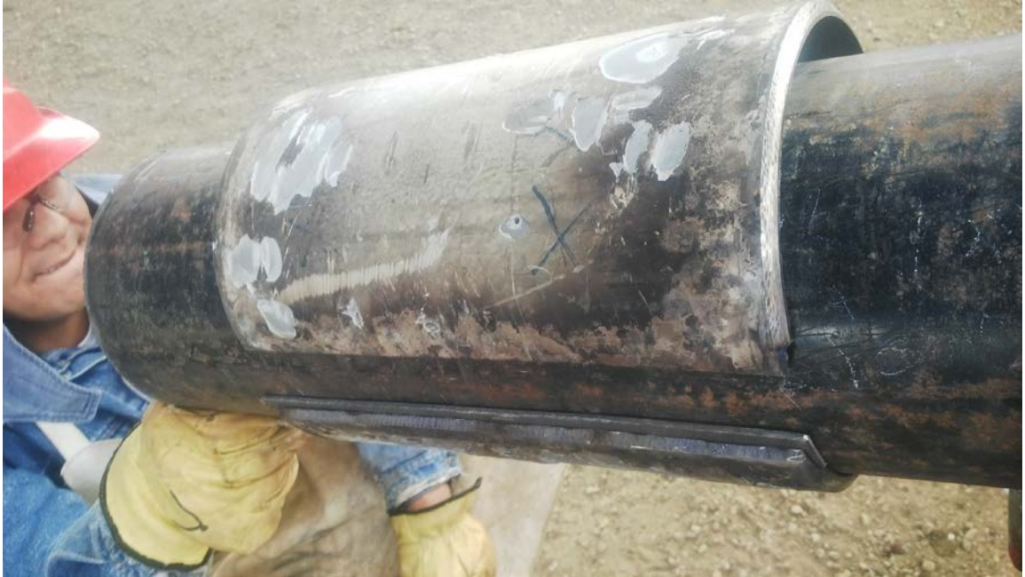
Figura 17. Ensamble de Cascota a Tubo Conductor.
