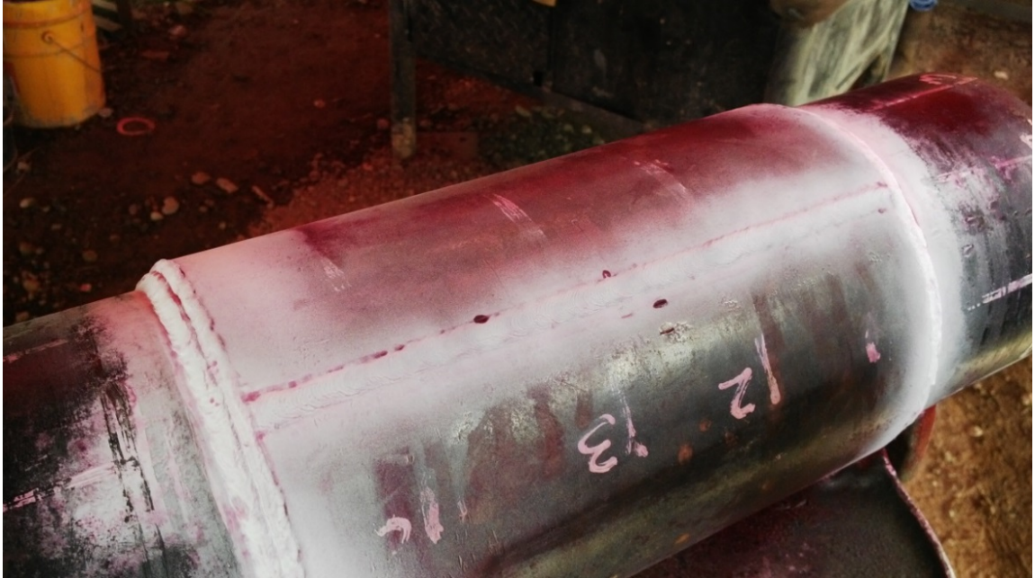
Figura 31. Inspección por Tintas Penetrantes
