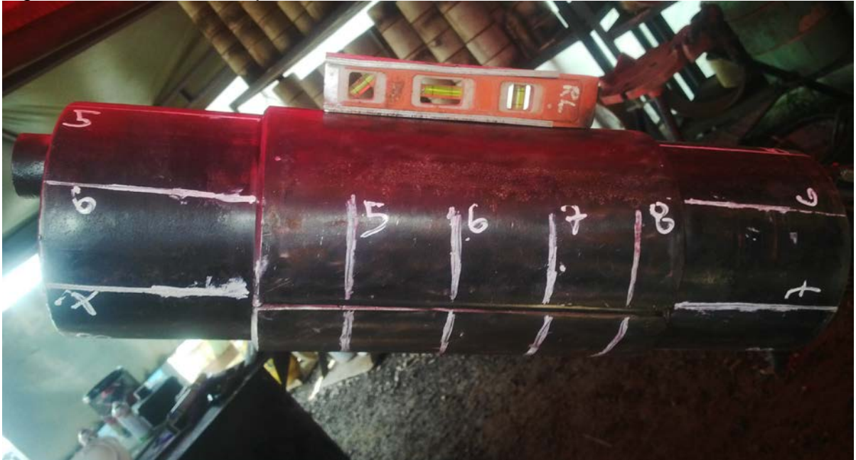
Figura 20. Instalación Cupón de Prueba.
