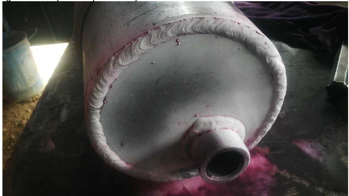
Figura 19. Inspección por tintas penetrantes
