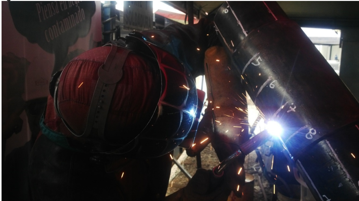
Figura 26. Soldadura en Junta Ranura
