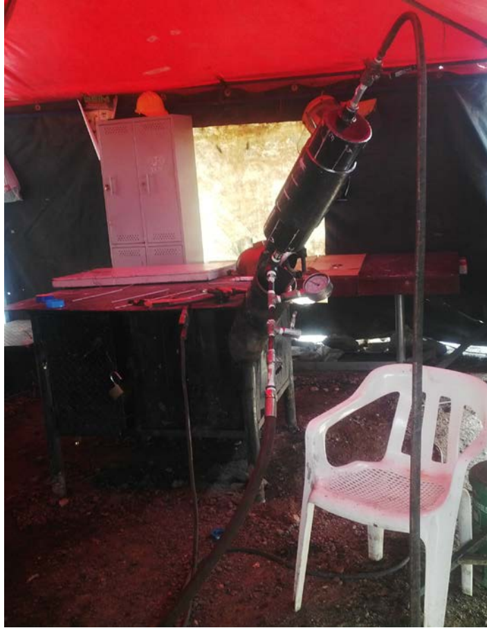
Figura 23. Instalación Cupón de Prueba – Árbol de Prueba
