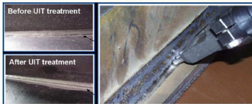
Figura 5 Aspecto antes y después del método UIT
