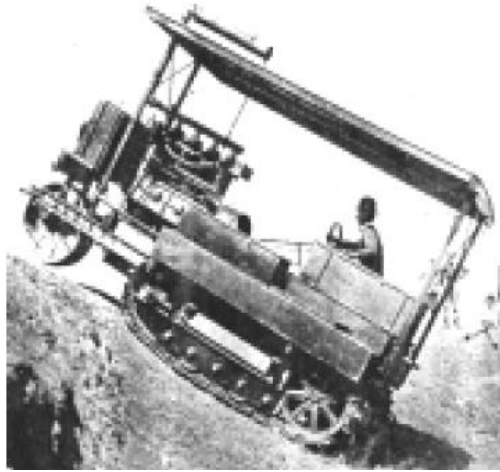
Figura 17 Primer Bulldozer http://www.monografias.com/trabajos-pdf/maquinaria-equipos-construccion/maquinaria-equipos-construccion.pdf
