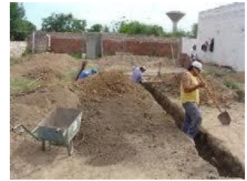
Figura 7. Excavación Manual
