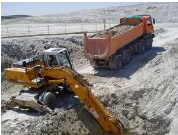
Figura 6.Excavación, Dovea Constructions 2007
