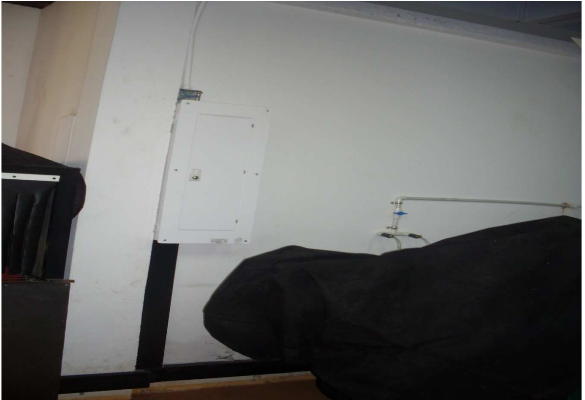
Cuarto 1 costado sur
