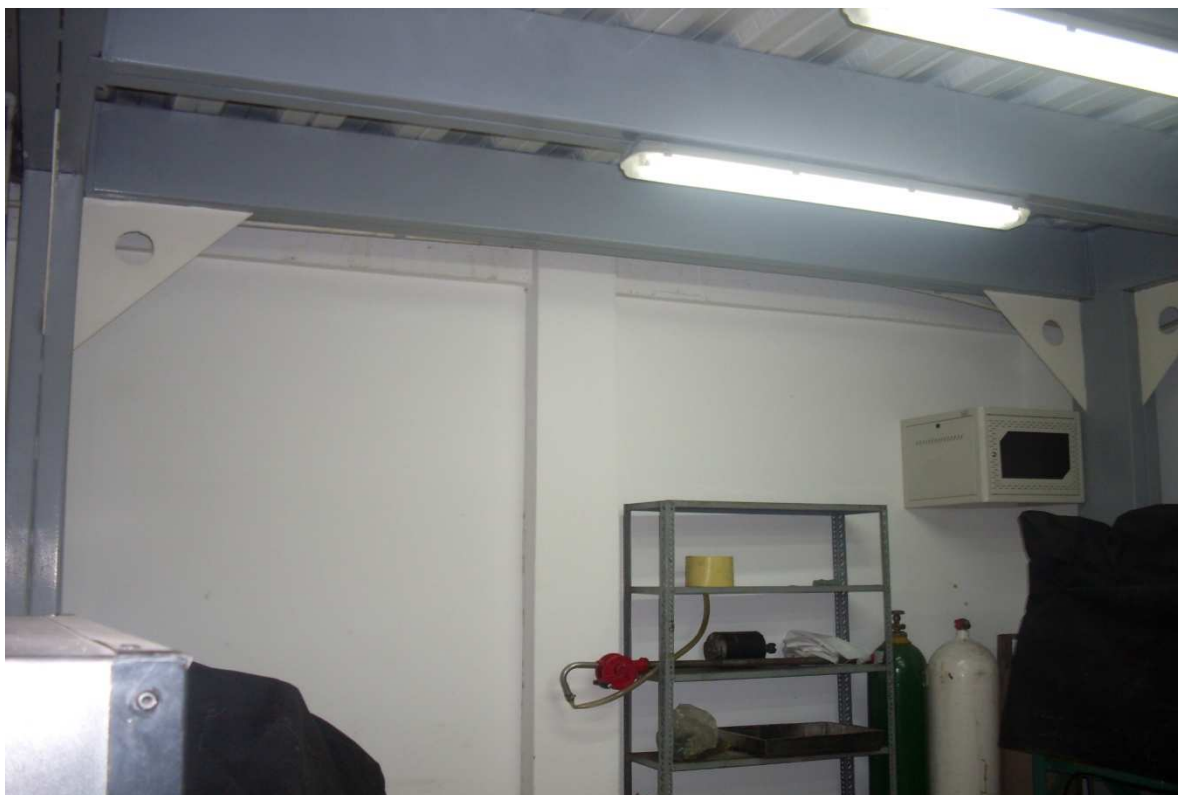
Cuarto 1 costado occidental
