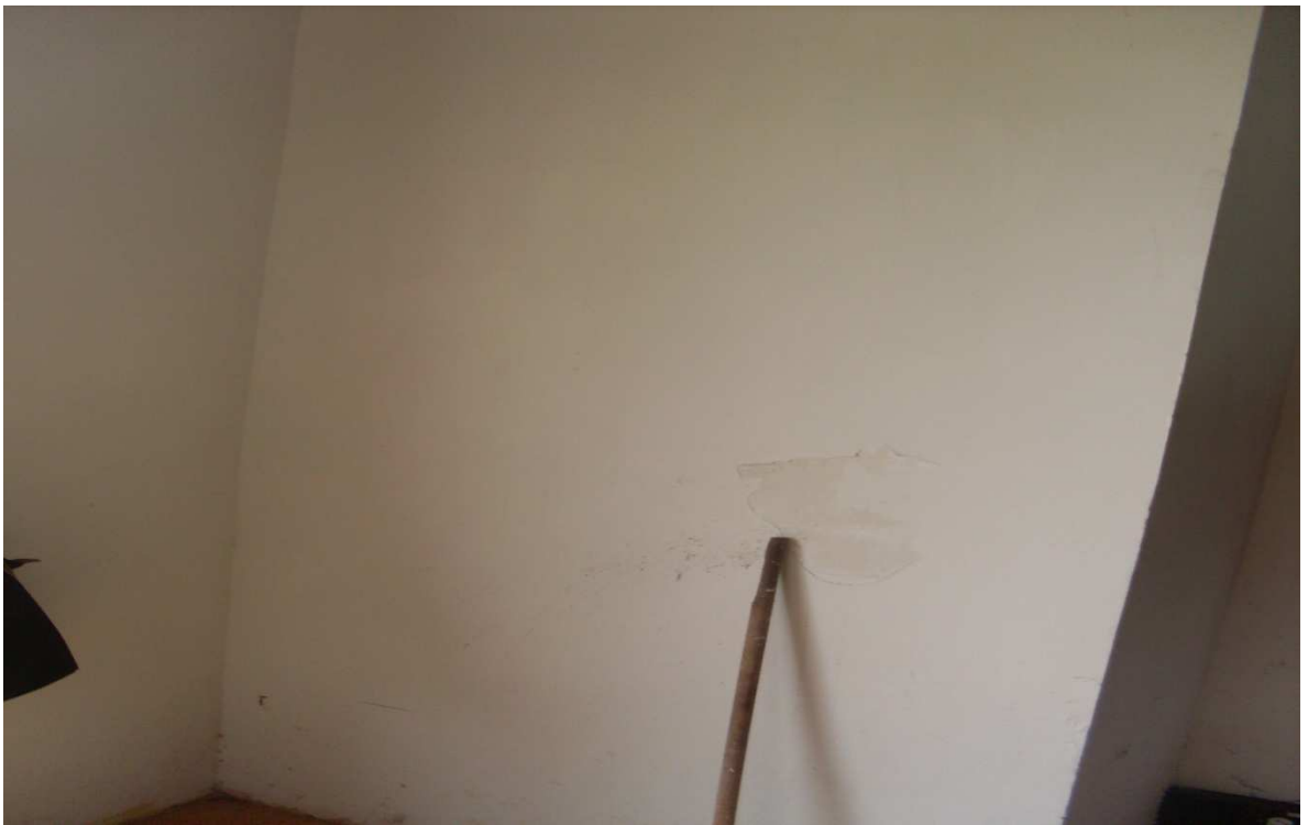
Cuarto 1 Esquina suroccidental
