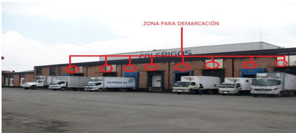
Figura 24. Foto muelle sin demarcar
