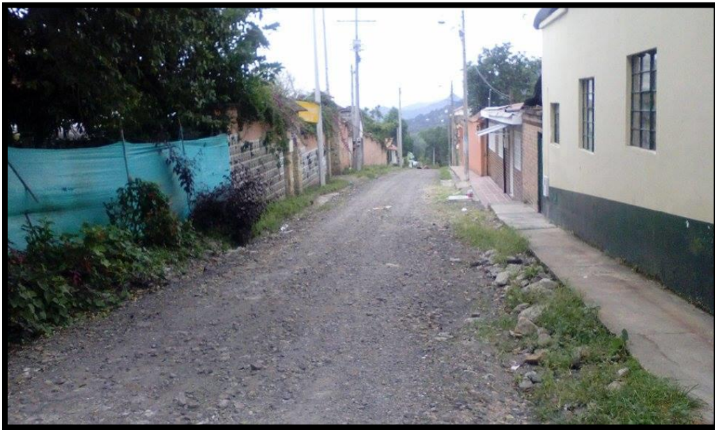
Fotografía 4 Tomada desde Calle 2 con Carrera 10, zona de inundación y encharcamiento.
