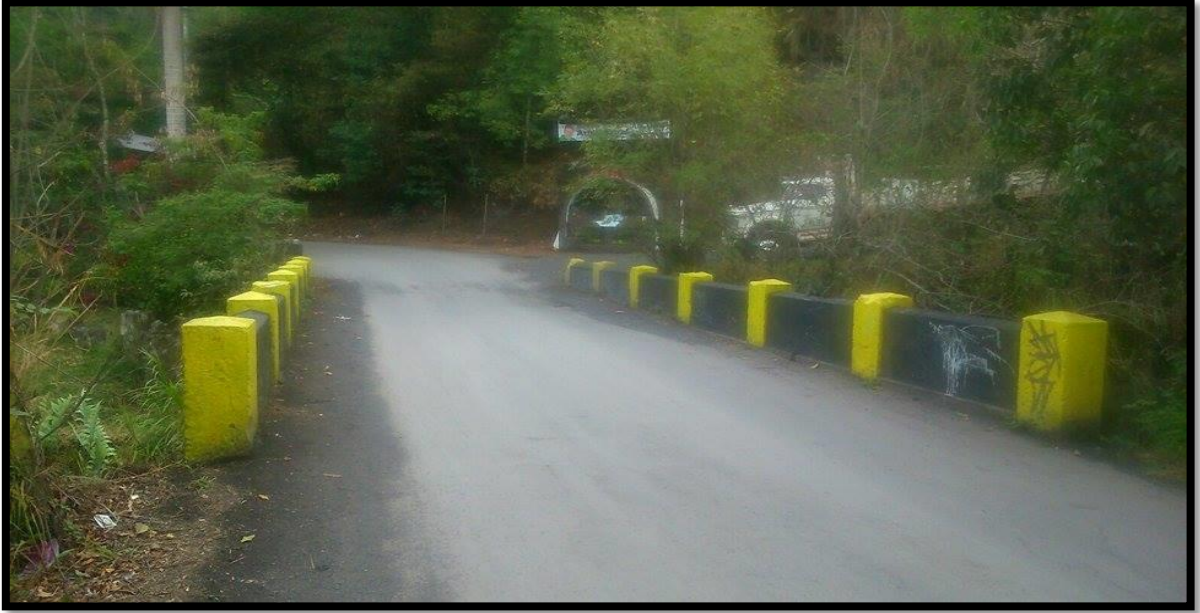
Fotografía 11 Puente vehicular a la entrada del municipio por el Norte del área urbana.
