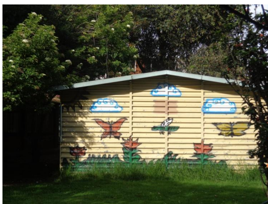
Gráfico 4. Vista de las casetas desde el patio central 147
