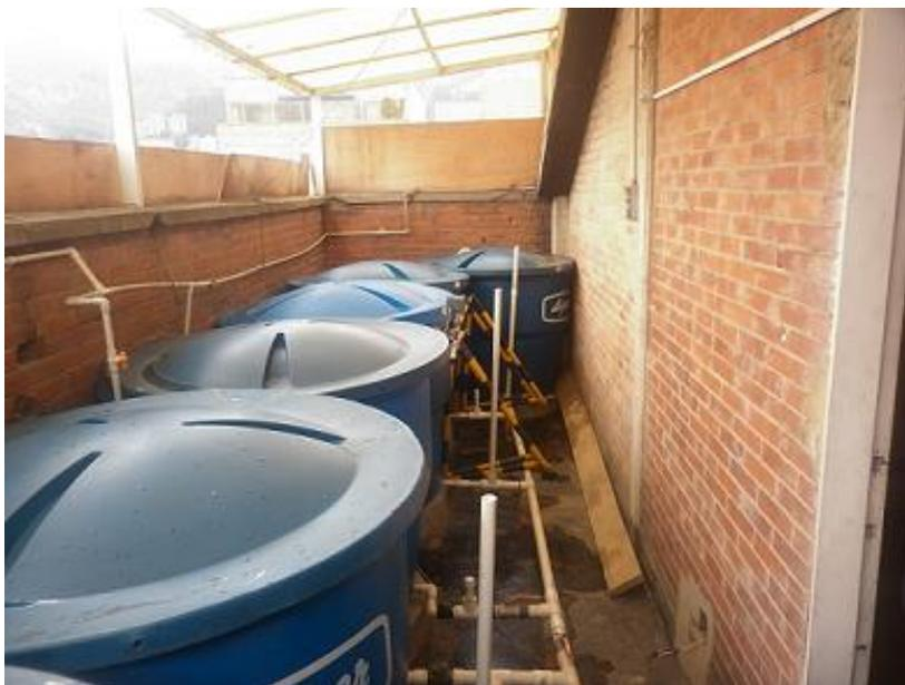
Fotografía 3. Tanques de reserva de almacenamiento de agua potable de Oficentro II.
