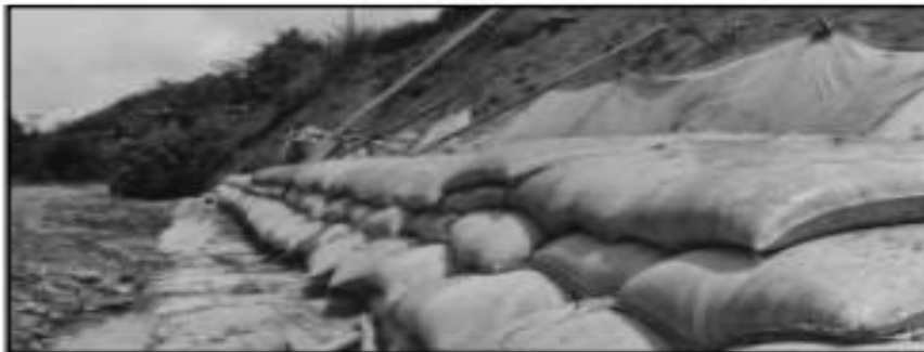
Ilustración 26 Estructura Bolsacretos
