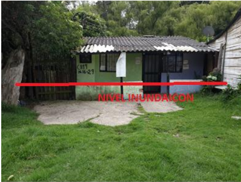
Ilustración 34 ZONA INUNDADA EN EL 2011
