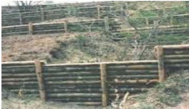
Figura 13. Trincho en guadua 16
