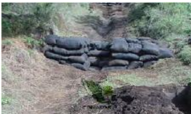
Figura 27. Dique de sacos 28
