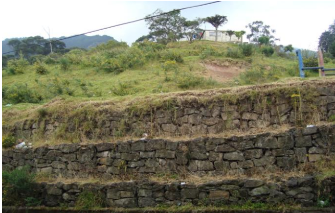
Figura 32. Muro de contención tipo gavión
