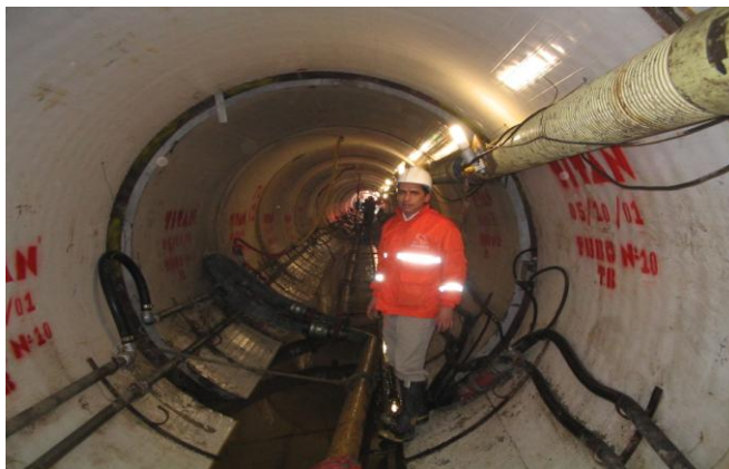
Figura 44. Vista interior de un interceptor en construcción
