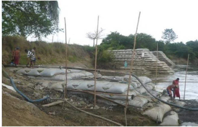
Figura 38. Espolones para la desviación de líneas de flujo del río 35
