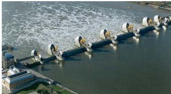
Figura 43. Obra para el control de inundaciones aguas abajo 36
