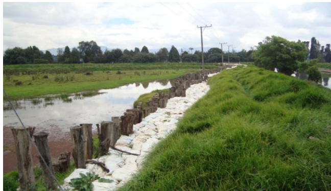
Figura 41. Obras para controlar el cauce y las socavaciones
