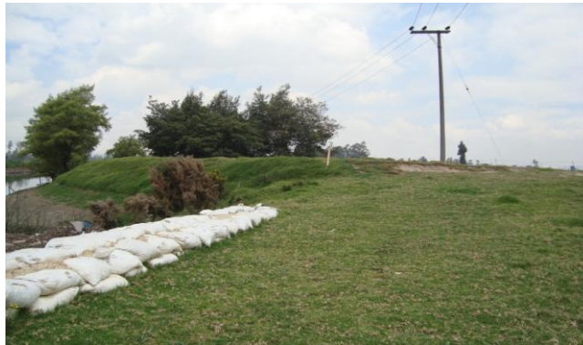
Figura 39. Espolón para favorecer la sedimentación
