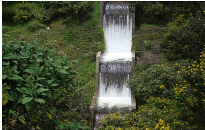
Figura 37. Obras para el control de caudales torrenciales
