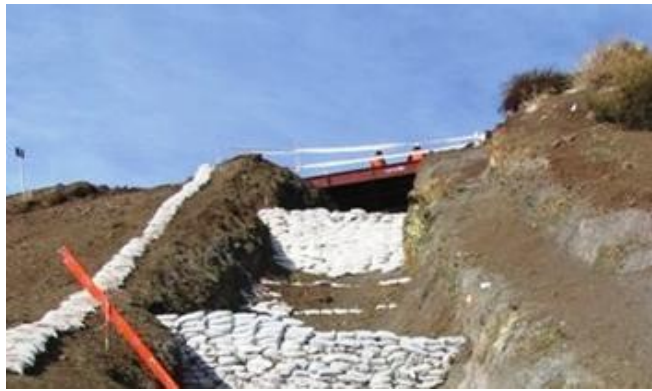
Figura 29. Diques en suelo cemento 30
