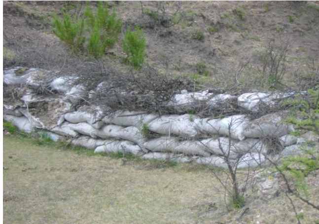
Figura 20. Barrera de costales rellenos de material 22
