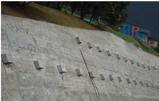
Figura 33. Muro de contención anclado
