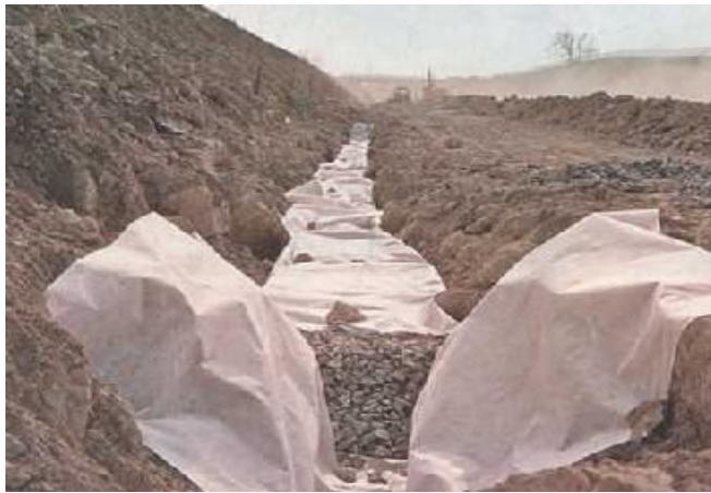
Figura 21. Construcción de un filtro sub-superficial 23
