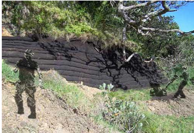
Figura 35. Terraplén reforzado con geotextil 34
