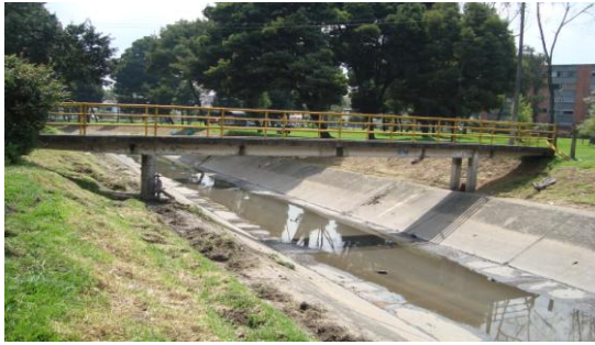
Figura 42. Obras de protección del lecho de un río
