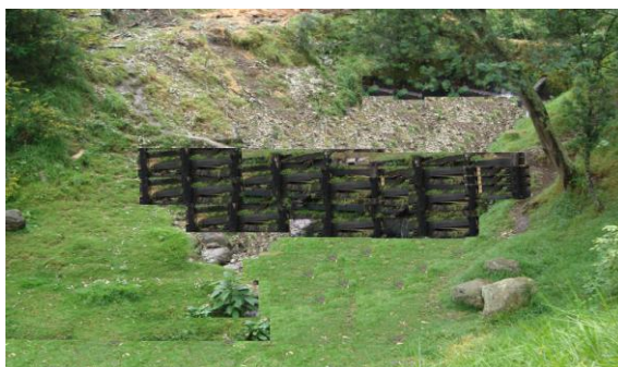
Figura 26. Dique de Madera y Troncos
