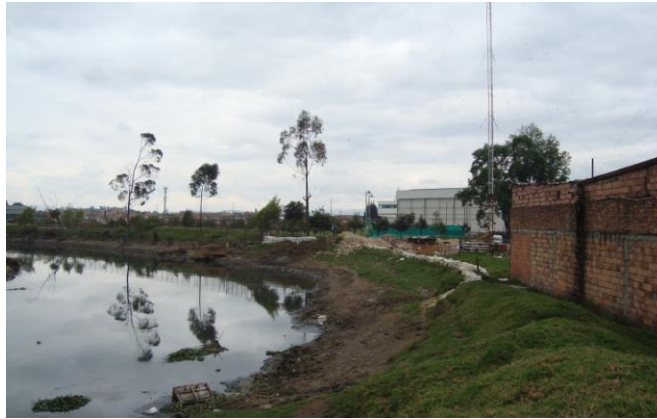
Figura 36. Vivienda riveraña afectada por la corriente de agua
