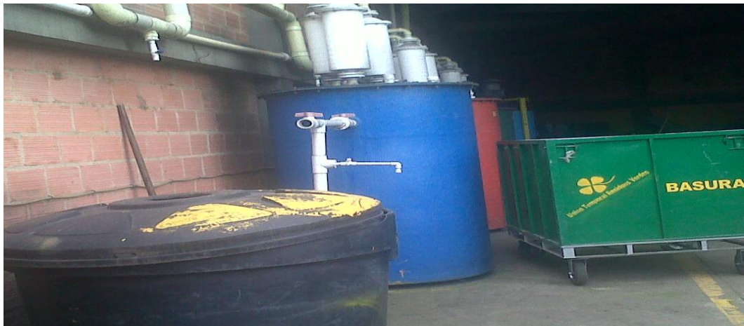
Imagen 1 (Centro de compostaje de la central de acopio no utilizado)
