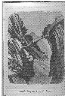
Hangende brug van Ruwo bij Simoda 下田近くの竜王の吊り橋
