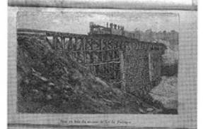
Pont en bois du chemin de fer du Pacifique. パシフィック鉄道の木製の橋
