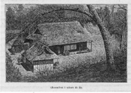
Chaumieres à toiture de lis. 百合の屋根の藁葺きの家
