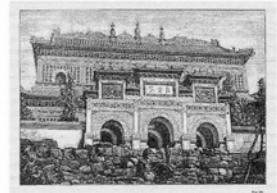
La chapelle du Palais d'Ete. 夏の宮殿[頤和園]の礼拝堂
