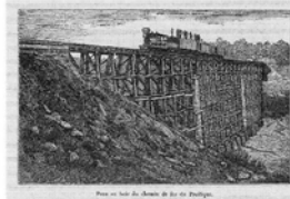
Pont en bois du chemin de fer du Pacifique. パシフィック鉄道の木製の橋
