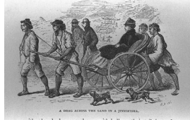
A drag across the sand in a Jinrikisha. 人力車で砂地を引っ張って 渡る
