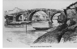
Pont sur le Schow Creek. ショウクリーク[蘇州河]に架かる橋
