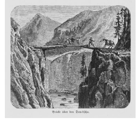
Brücke über den Den-dschu. 定曲にかかる橋
