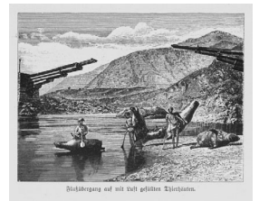
Flussübergang auf mit Luft gefüllten Thierhäuten. 空気を詰めた革袋に乗っての渡河
