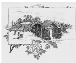
Kantai-bashi. カンタイ橋 [錦帯橋]
