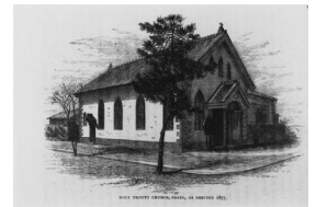
Holy Trinity Church, Osaka, as erected 1877 聖三位一体教会、大阪、1877建立
