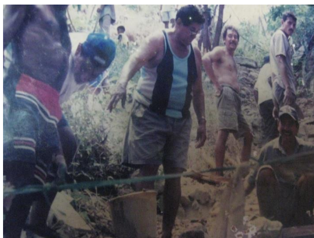
En esta foto los residentes del cerro empiezan a colocar las mangueras del agua por toda la trocha para abastecer las familias. 1998. Fotografía de Eduardo Agudelo
