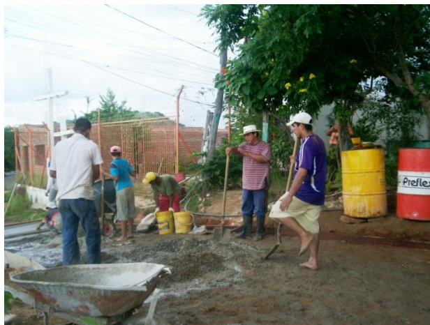
Residentes del cerro trabajando en la construcción de la planta par el colegio y arreglo de la rocha. Agosto de 2008
