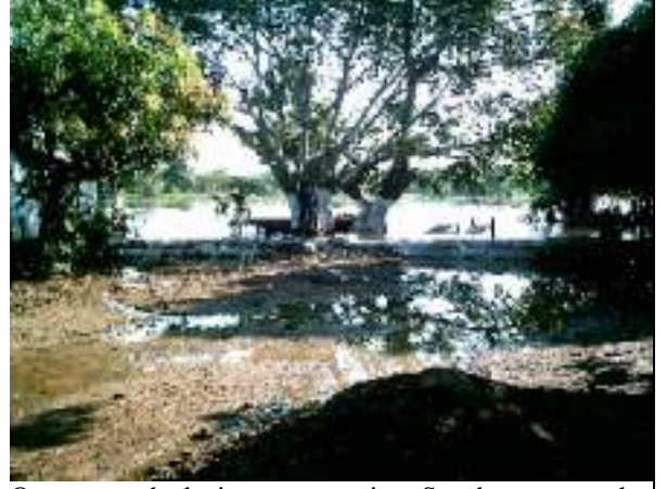
Otra toma de la imagen anterior. Se observa que la defensa construida con sacos de arena, protege a la Población.
