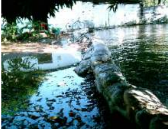
En la imagen, se presenta como ingresan las aguas del Río Magdalena (del lado izquierdo de la fotografía), en este tramo no existe ningún tipo de protección
