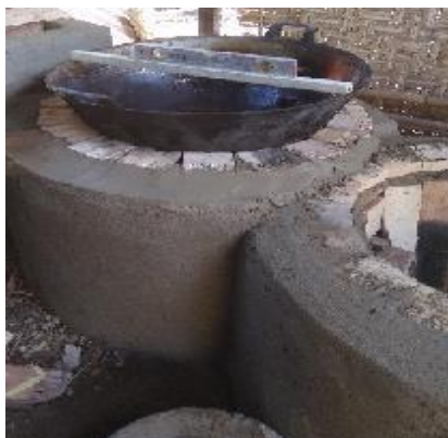
Gambar 5. Ruang Bakar Kedua Telah Rampung, Dilanjutkan Dengan Pengemalan Tempat Dudukan Wajan
