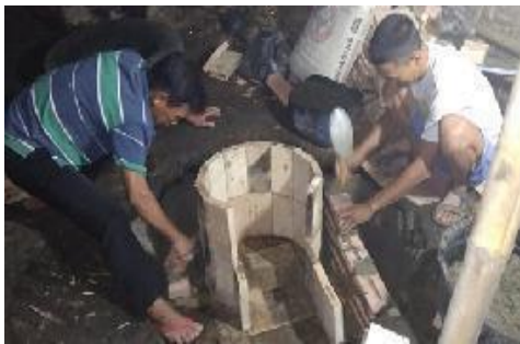
Gambar 3. Bata Tahan Api SK32 Disambungkan Antar Batu Tahan Api Menggunakan Castable.
