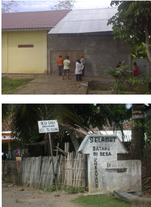
Keterangan gambar 11: Gudang padi lantai jemur di desa Embawang
